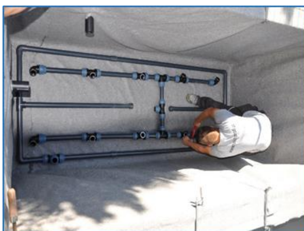
Rückspüleleitung und Filtergestell zentral legen und die Verschraubungen festziehen
