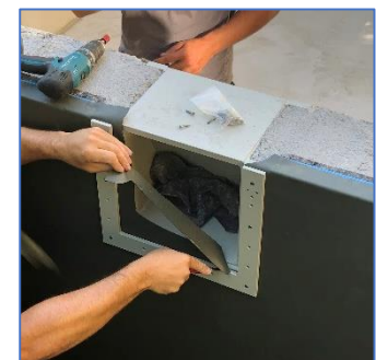
Folie mit einem Cutter ausschneiden.
