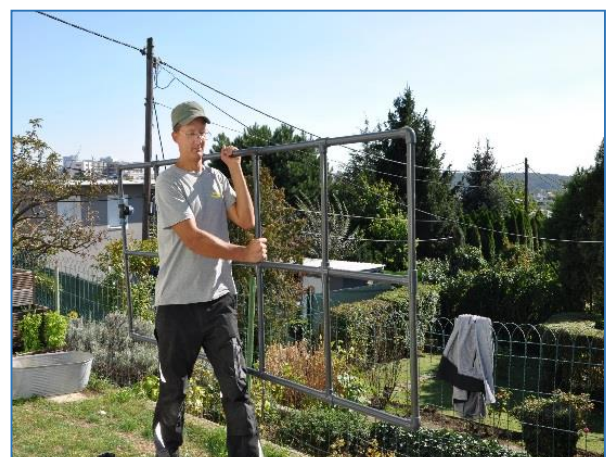
Als nächstes Bubble Leitung einbringen, mit den Löchern nach unten!!
