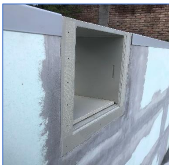
Skimmerklappe vor der Folienerlegung.
