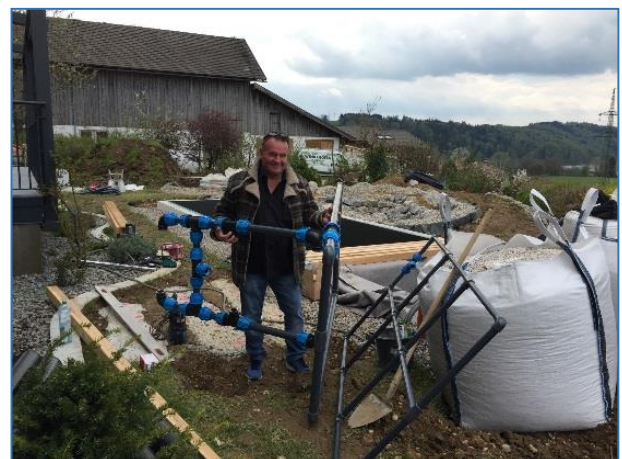
Einbringen der Rückspüleleitung und des Filtergestelles
