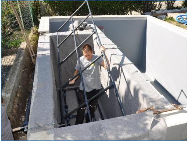
Bubble Leitung in den Skimmerteich einbringen
