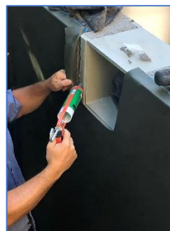
Zwischen Folie und Skimmerklappe mit TEC7 zusätzlich abdichten.
