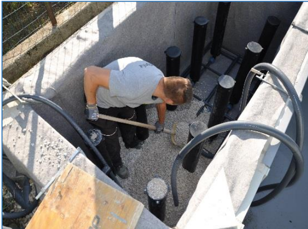
Alle Schläuche beschriften, damit sie später nicht vertauscht werden, Schotter gleichmäßig verteilen.
