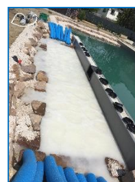
Abb.8 Skimmerteich eines TEOC Naturpools beim Bubbeln (Rückspülen)...
