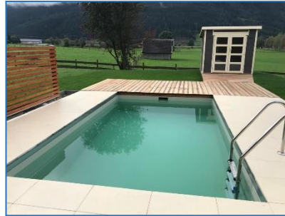
Bündiger Einbau - Platten müssen mit 3% Neigung = 3 cm./m 1,72° vom Naturpool geneigt verlegt werden
