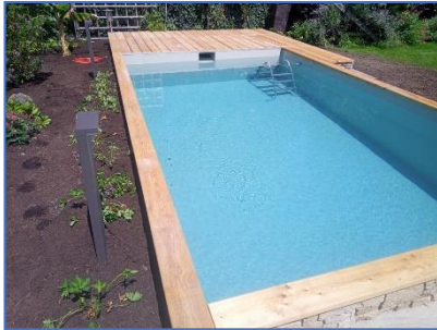
Normaler Einbau +10cm - 15cm Überstand
