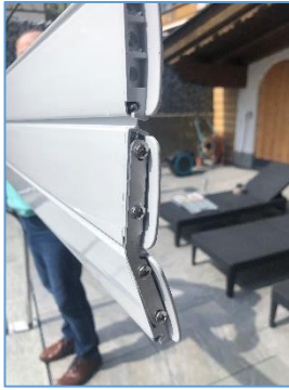
Als letztes wird das Endstück welches in dem Paket mit der Nr.1 geliefert wird montiert.
