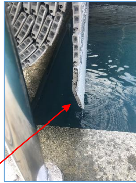
Als letztes wird das Endstück welches in dem Paket mit der Nr.1 geliefert wird montiert.
