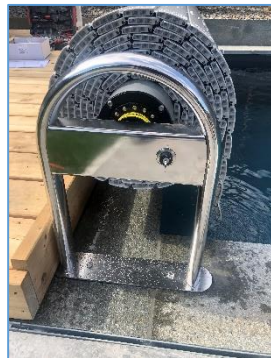
Als letztes wird das Endstück welches in dem Paket mit der Nr.1 geliefert wird montiert.
