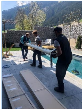
Rollabdeckung herausnehmen und so transportieren dass die Wickelwelle sich nicht von den Laufrädern löst.
